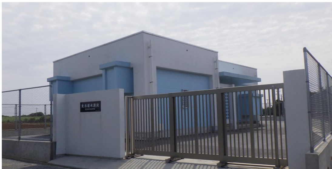
宮古島市上下水道部 東添道水源地
