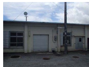
加治道浄水場の 送水ポンプ棟
