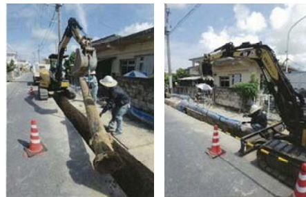
老朽管更新状況
