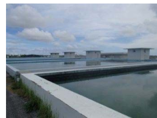
袖山浄水場の緩速ろ過池
