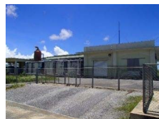
稼働休止中の 伊良部浄水場
