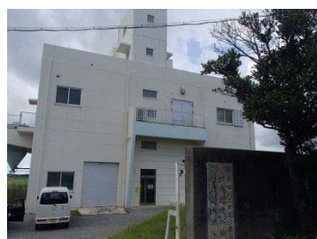
加治道浄水場 (管理棟)
