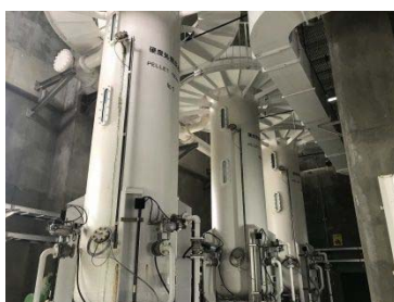
加治道浄水場 (硬度低減化施設)
