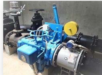
緊急遮断弁 (牧山配水池)
