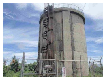
与並武岳配水池
