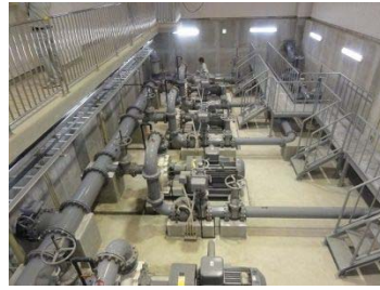
袖山 - 東部・北部ポンプ 東部：建設年度 平成元（1989）年度 北部：建設年度 平成 4（1992）年度
