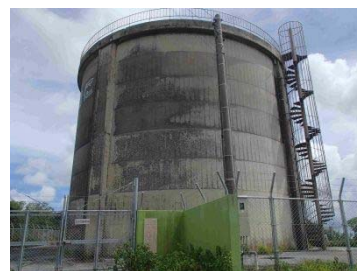
二重越配水池
