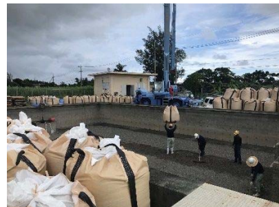
加治道浄水場におけるろ過砂入れ替え状況
