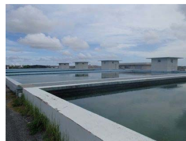
袖山浄水場 (緩速ろ過池)
