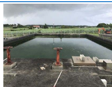
加治道浄水場 (緩速ろ過池)
