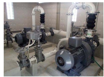
久松ポンプ場 建設年度 平成 24（2012）年度
