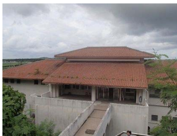
袖山浄水場 (硬度低減化施設)
