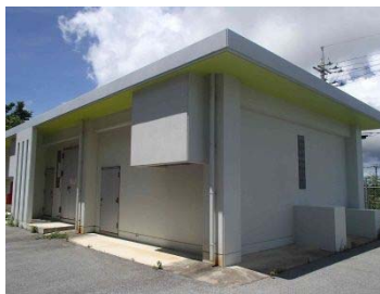
久松ポンプ場 建設年度 平成 24（2012）年度
