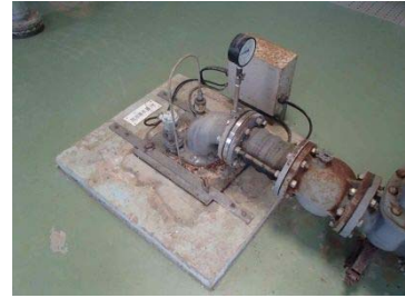
加治道 - 1 号ポンプ 建設年度 昭和 40（1965）年度
