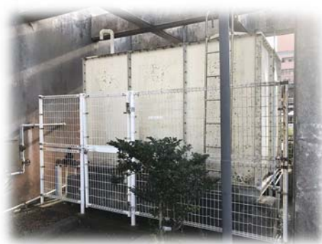
貯水槽水道の受水槽
