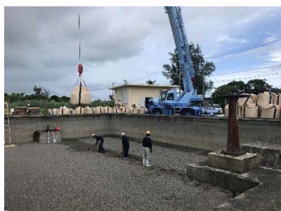
加治道浄水場におけるろ過砂入れ替え状況
