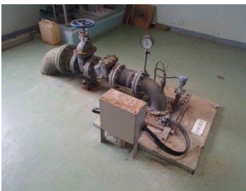
加治道 - 2 号ポンプ 建設年度 昭和 40（1965）年度
