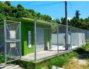
前浜ポンプ場 建設年度 昭和 49（1974）年度
