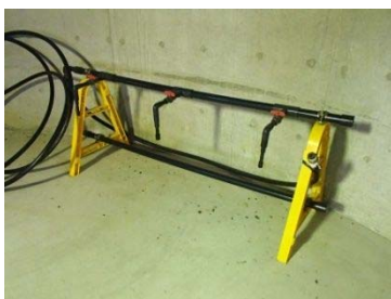
応急給水栓 (池間配水池)
