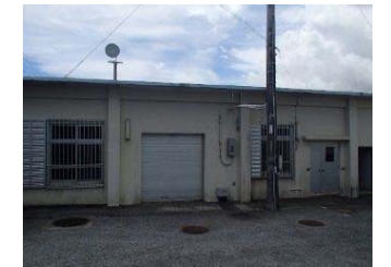
加治道浄水場の送水ポンプ棟
