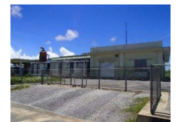
稼働休止中の伊良部浄水場
