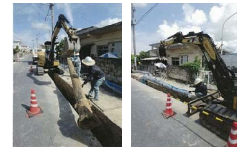
老朽管更新状況
